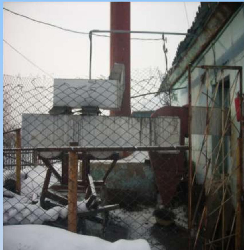
**Котельная МБОУ Моисеевская СОШ – установлены два котла марки КВр-034 Гкал/час. на твердом топливе, дымососы, дымовая труба, золоуловители**
