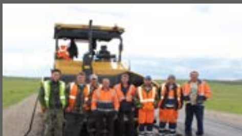
Строительство дороги Залари – Бажир – Кр. Поле с 1 по 2 км.
