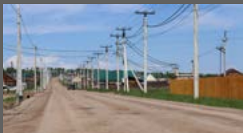
Ремонт ул. Зеленая. мкр Солнечный, в р.п Залари
