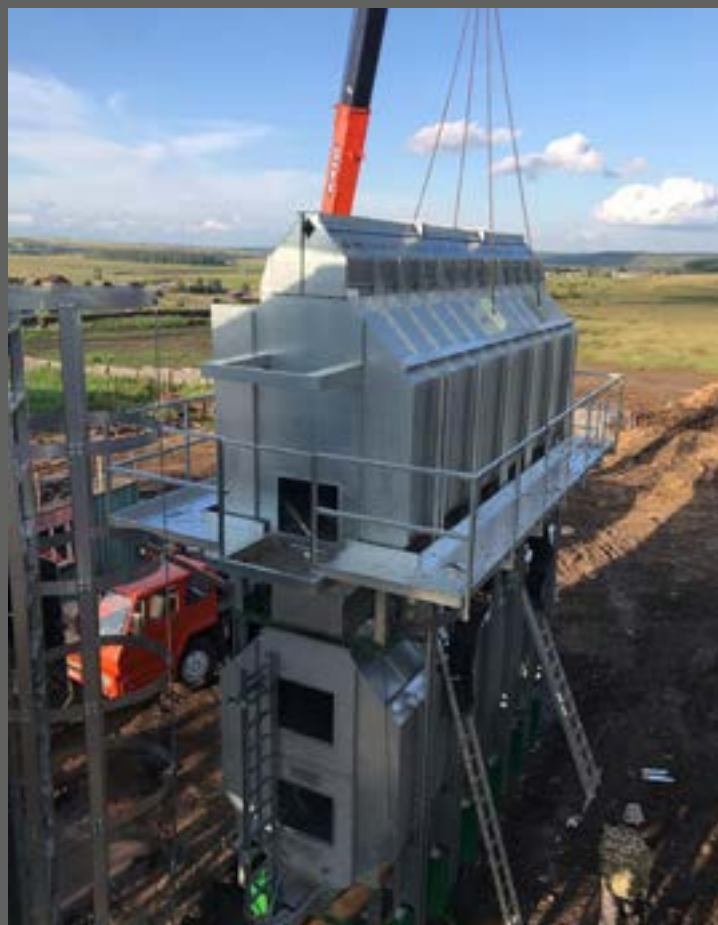
Строящийся элеватор ИП глава КФХ Распутин А.В
