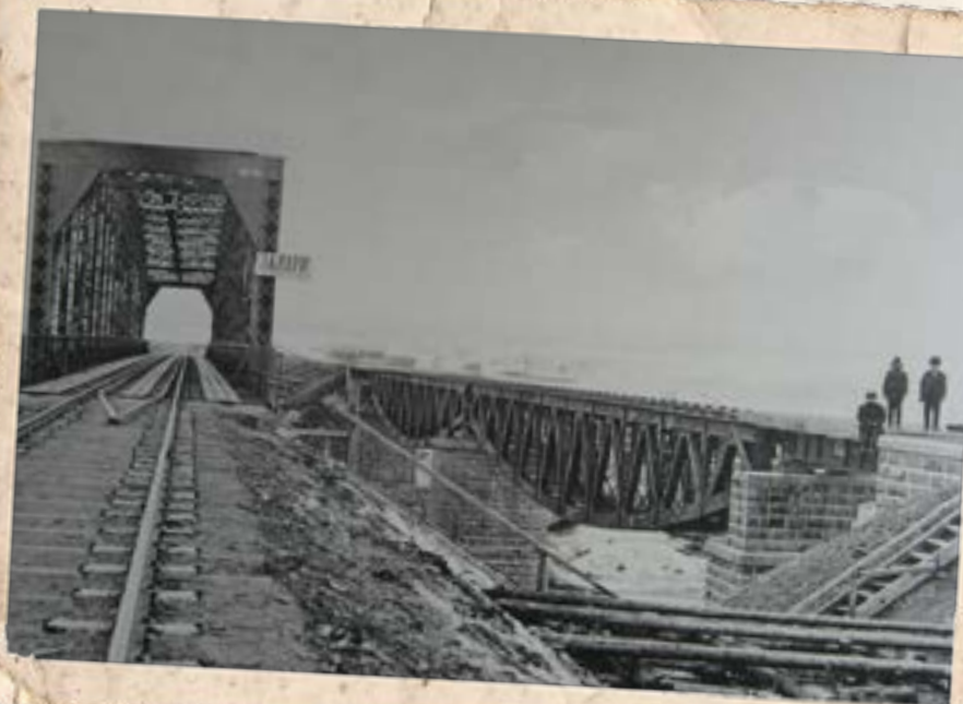
Сооружение моста через р. Залари. Строительный период 1908 год.
